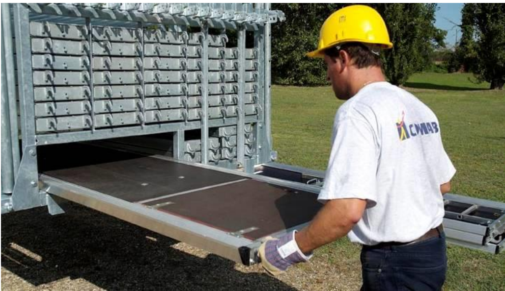
4 – Verrouiller les planchers avec les équerres de blocage
