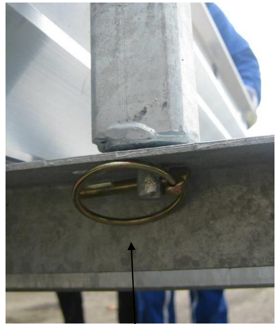
Goupiller les tubes de blocage latéral.
