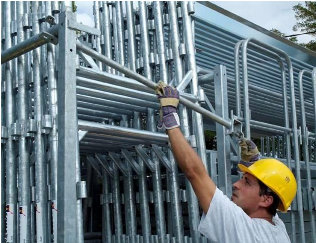
11 – Verrouiller les cadres avec une barre à clavette.
