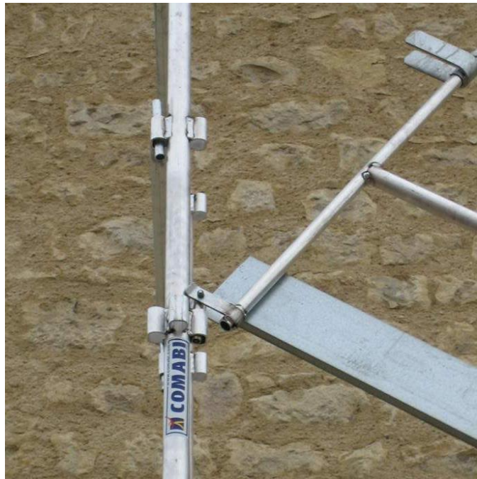
24-Poursuivre par le montage des garde-corps...sur les 3 travées
